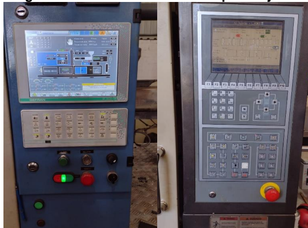
Figura 4 – Quadro elétrico da máquina injetora
