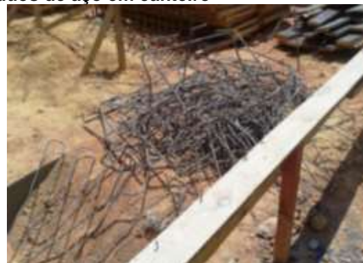
(b) Obra B – Sobras de aço no canteiro
