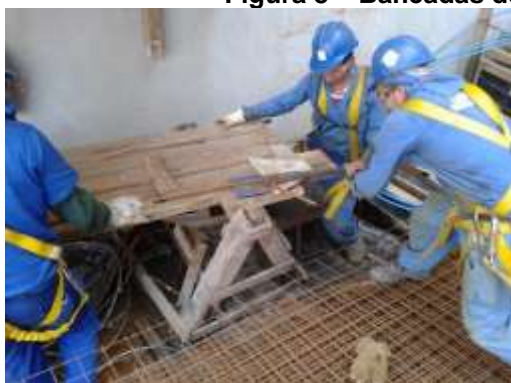
(a) Obra A
