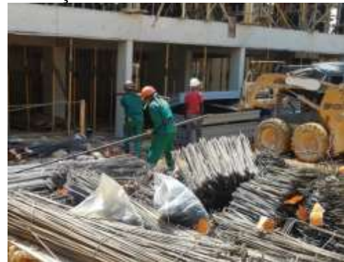
(b) Obra B – Movimentação individual
