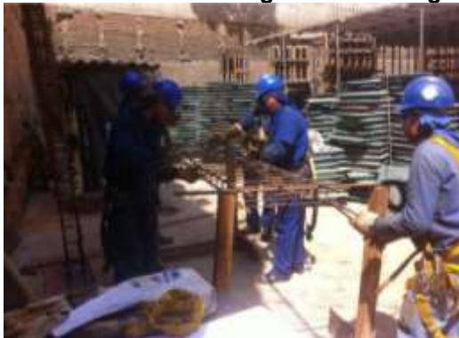
(a) Obra A – Montagem de um pilar
