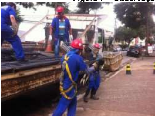
(a) Obra A – Recebimento do aço
