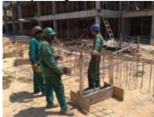
(b) Obra B – Montagem de uma viga
