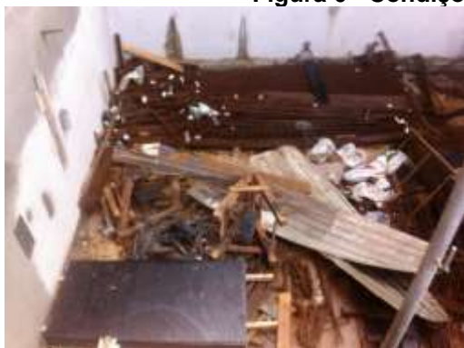
(a) Obra A
