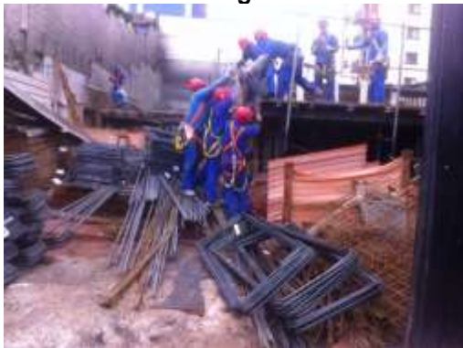
(a) Obra A – Movimentação em grupo
