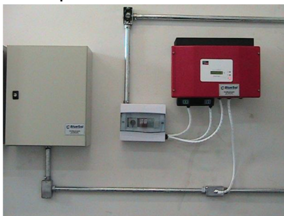
Figura 1 – Exemplo de encaminhamento de cabos a painéis
