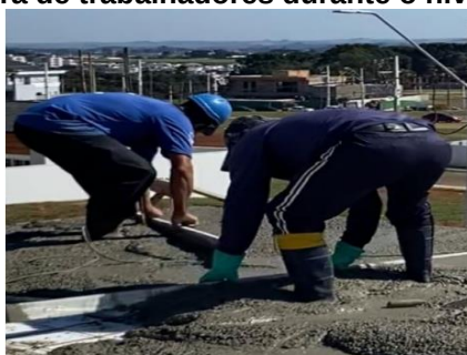
Figura 4 –Postura de trabalhadores durante o nivelamento da laje
