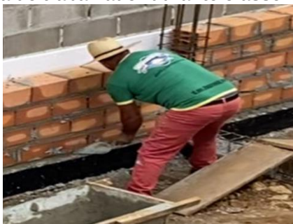
Figura 1 – Postura de trabalhador durante o assentamento de tijolos
