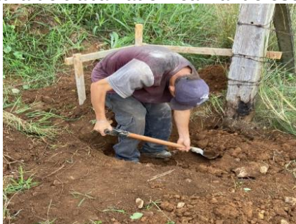
Figura 3 – Postura de trabalhador realizando escavação manual
