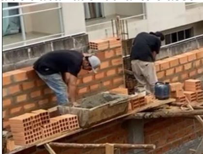
Figura 2 – Postura de trabalhador durante o assentamento de tijolos
