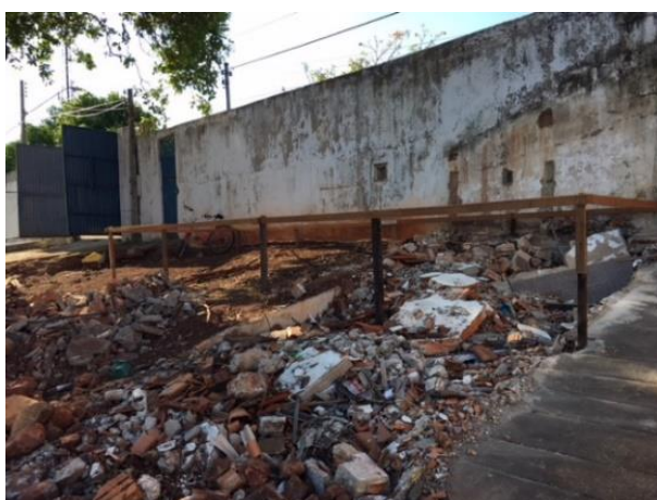
Figura 2 – Gabarito aguardando liberação de projeto
