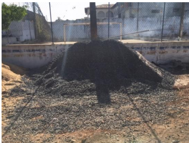
Figura 1 – Brita acondicionada sem baia de retenção
