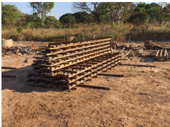
Figura 5 – Ferro para vigas
