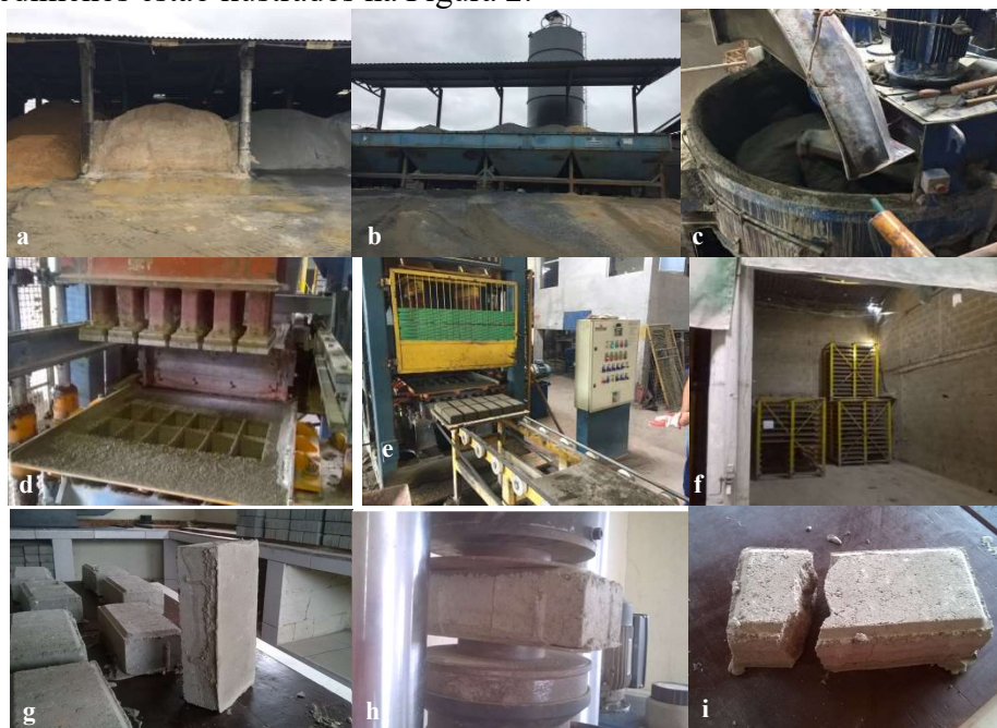
Figura 2 - a) Baías estoque agregados para produção de paver; b) Silos de agregado e cimento e central de concreto; c) Concreto sendo misturado; d) Molde e contra molde paver 6 cm; e) Paver sendo produzido por processo de vibro compactação; f) Racks com pavers do estudo, armazenados na câmara de cura; g) Exemplo paver capeado com argamassa, para regularização da base; h) Amostra de paver após ensaio de rompimento: peça rompida de forma ideal, fissura no centro da peça e retilínea; i) Amostra após ensaio de rompimento.
