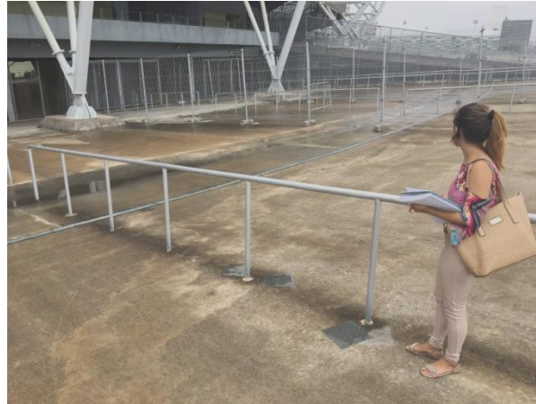
Figura 6: Rampas de entrada
