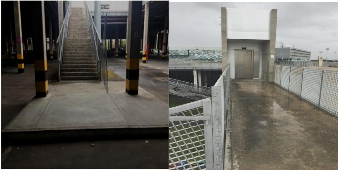
Figura 4: Escadas e elevadores de acesso.
