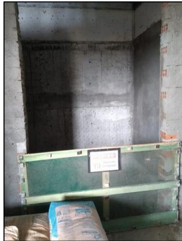
Figura 6 – Proteção contra acesso às caixas de elevador. Fonte: autoria própria
