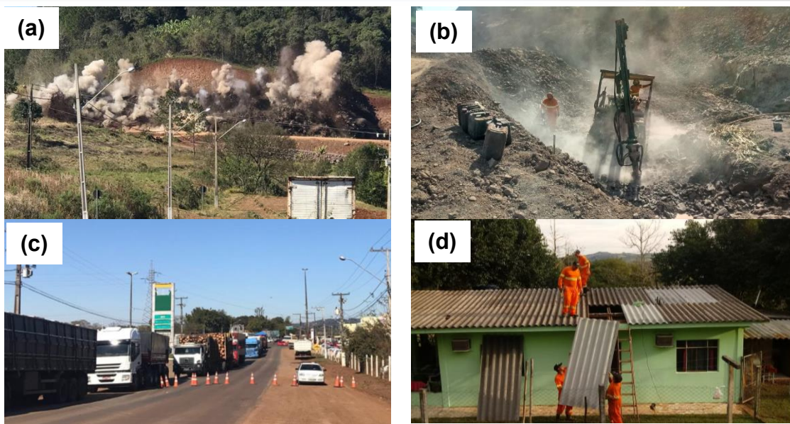
Figura 1 - Atividade de desmonte de rocha; (a) Desmonte com uso de explosivos; (b) Desmonte com o uso de peruratriz; (c) Interdição do fluxo durante o desmonte com explosivos. (d) Reparo de danos causados a vizinhança devido a fragmentos rochosos;
