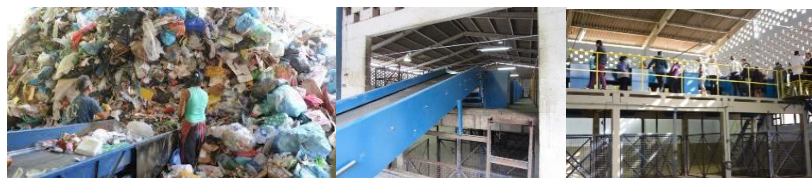
Figura 2 – Armazenamento dos materiais recicláveis, à esquerda (1); Esteira para a triagem de materiais recicláveis, no centro (2); Processo de triagem com as baias para seleção dos resíduos recicláveis, à direita (3)
