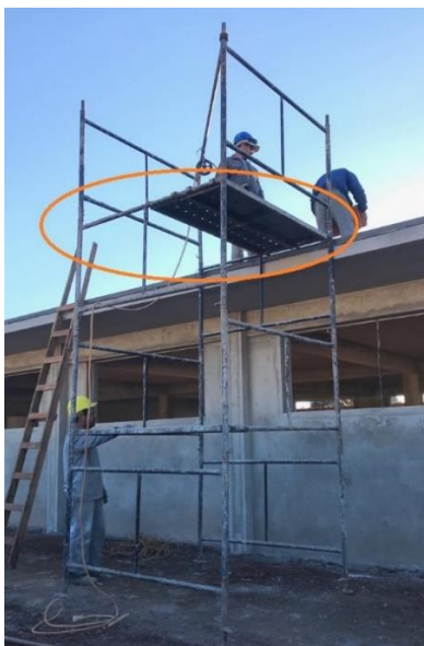
Figura 03 –Andaime Fonte: Autor (2018)
