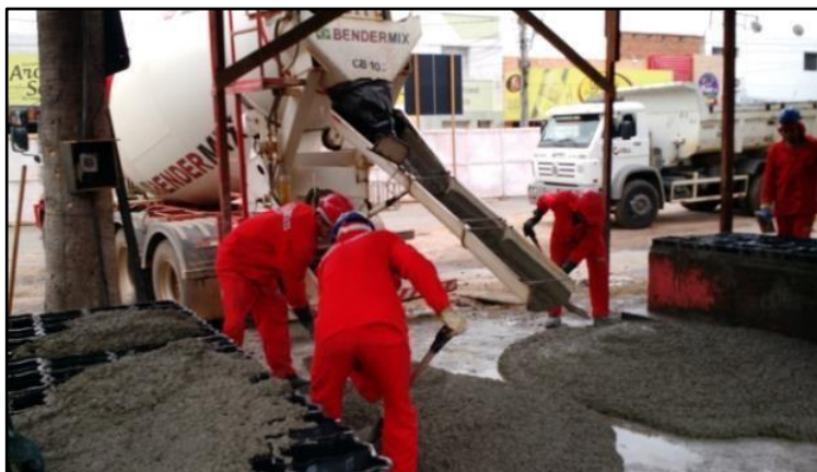
Figura 7: Uso de Pá no Manuseio da Argamassa
