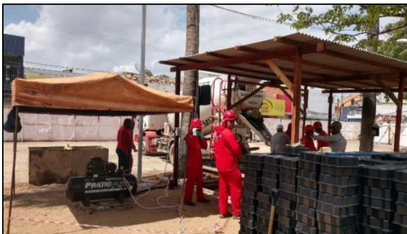
Figura 8: Trabalho com Carga Solar
