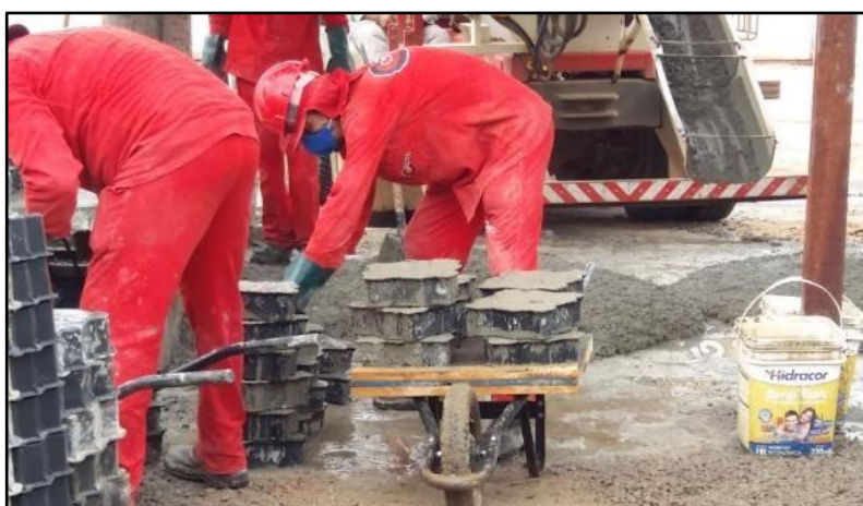
Figura 2: Colocação dos Moldes.
