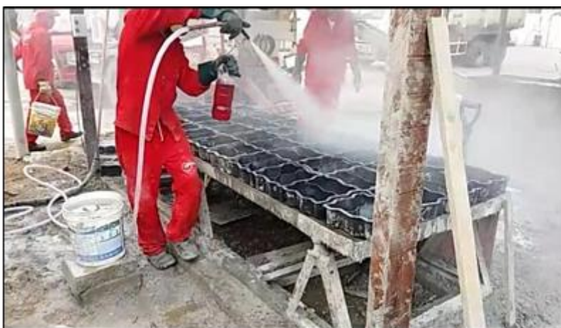
Figura 9: Lubrificação das Formas com Óleo Diesel
