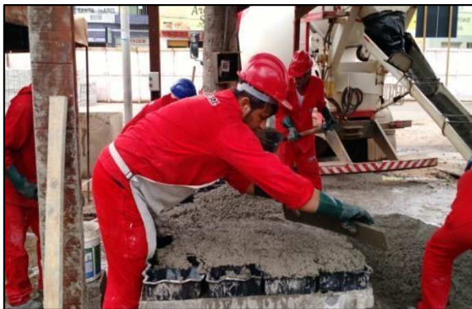
Figura 6: Espátula para Espalhamento do Concreto nas Formas
