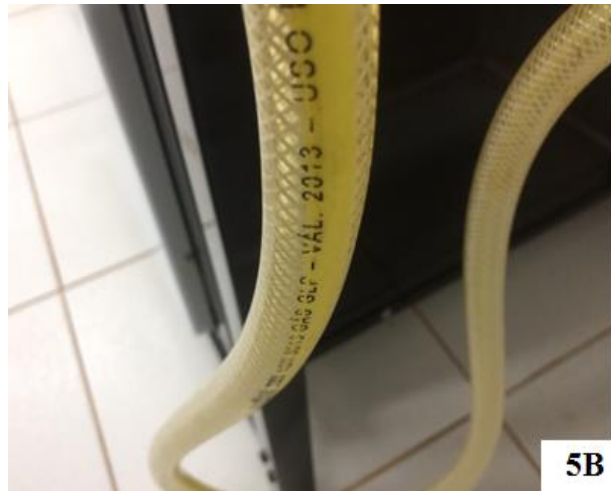
Figura 5 – Fiação elétrica inadequada (5A) e mangueira de gás vencida (5B)
