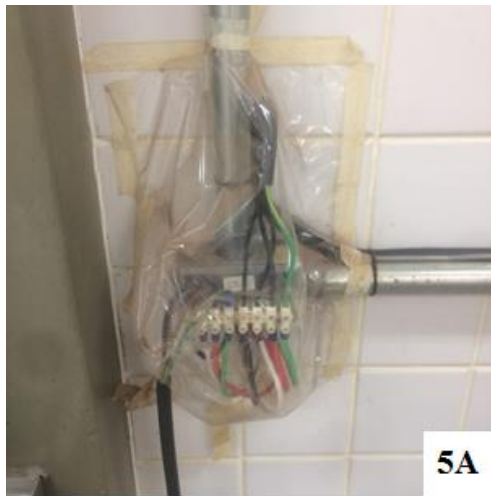
Figura 5 – Fiação elétrica inadequada (5A) e mangueira de gás vencida (5B)
