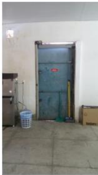
Figura 8 – Saída de emergência
