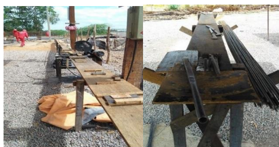
Figura 2 - A Esquerda: Setor de Corte/Medição. A Direita: Setor de dobra
