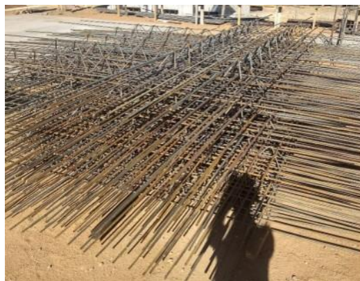
Figura 12 - Armação para Laje
