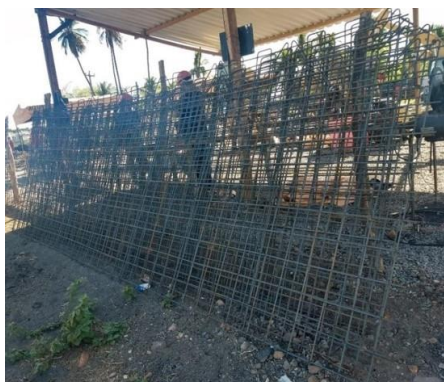
Figura 6 - Armação para Bloco
