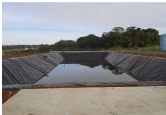
Figura 5 - Esterqueira de geomembrana Fonte: EMATER (s.d.)
