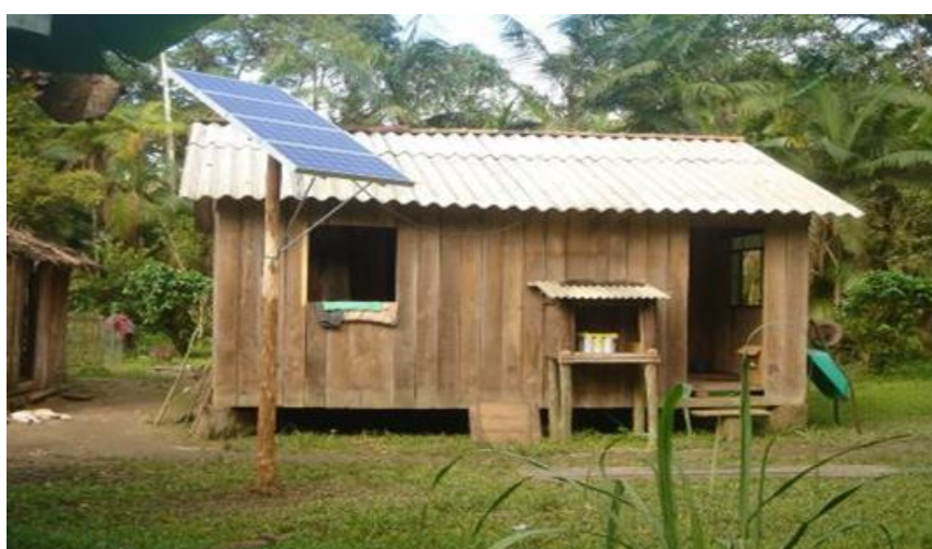
Figura 7 – Sistema fotovoltaico comunidade distante
