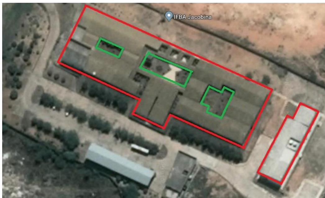
Figura 2 – Vista superior do telhado do IFBA Jacobina. Em verde os perímetros que já possuem calhas, e em vermelho os que não possuem.
