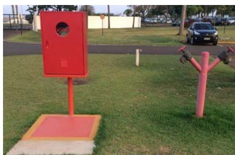
Figura 6 – Sistema de hidrantes Tipo 5 (SANDOZ, 2017)
