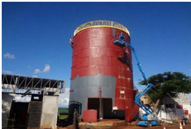
Figura 10 – Tanque de água, solda externa (MSE, 2017)
