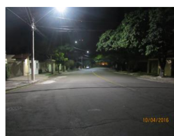
C- Trecho com LED (70 a 100W) e braço de 3m. (vista leste-oeste, n. 355)
