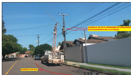
Figura 8 – Empresa 3, realizando substituição de Luminárias com Lâmpada Vapor de Mercúrio.
