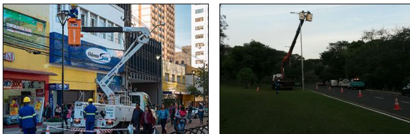
Figura 5 – Empresa 1, realizando substituição de Luminárias diversas [4].
