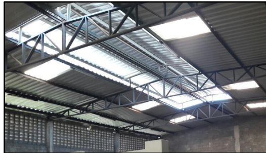
Figura 8 – Detalhe da Iluminação Natural do Galpão de Produção
