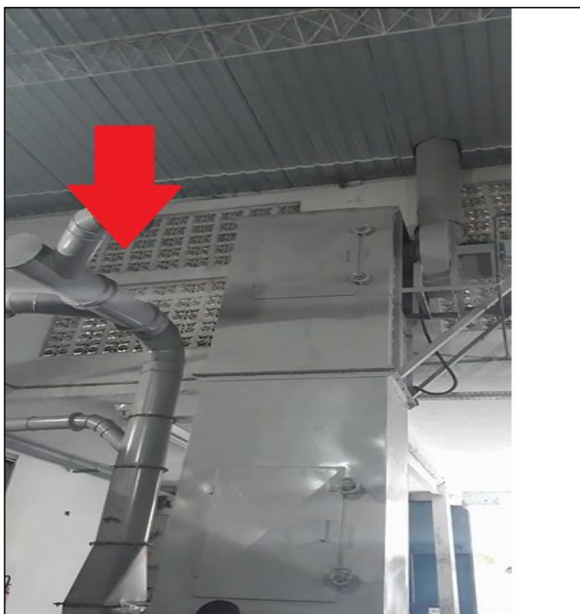
Figura 3 - Instalação de exaustores no Bamburi
