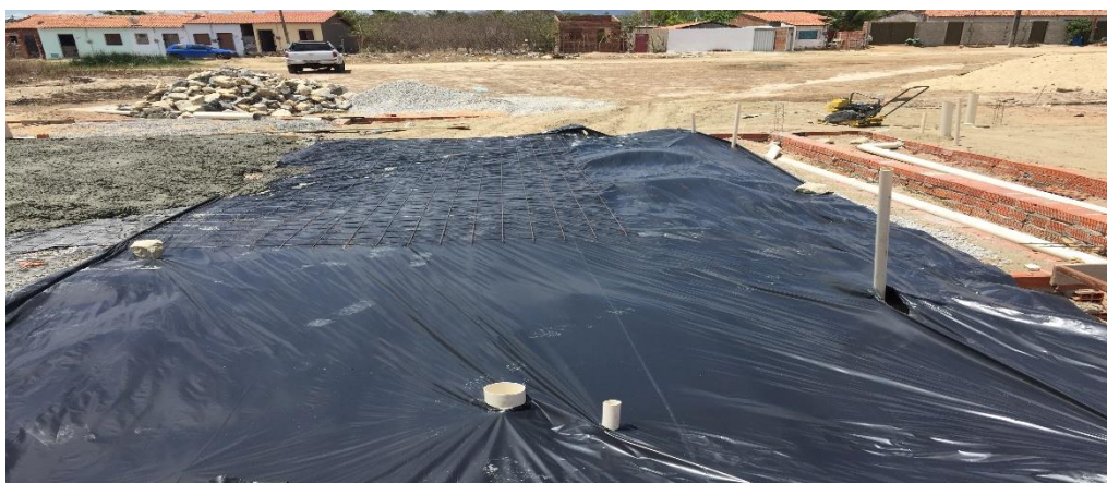
Figura 5 – Execução das fundações da edificação
