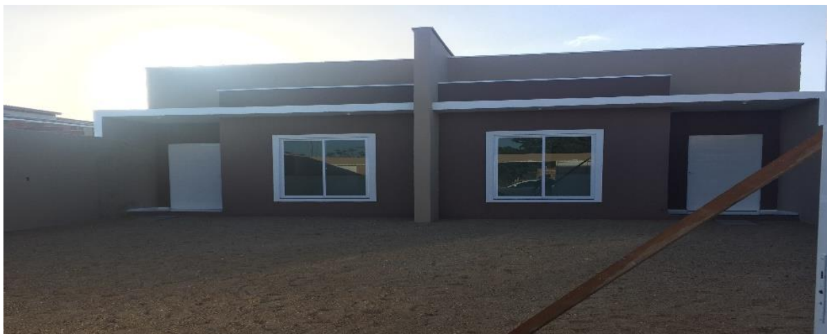
Figura 4 – Fachada da obra em execução
