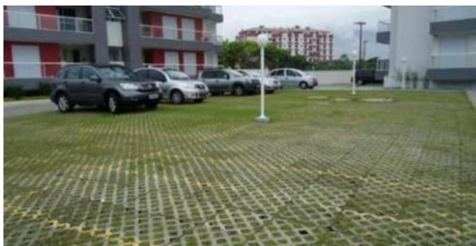
Figura 4 – Pavimento permeável em estacionamento
