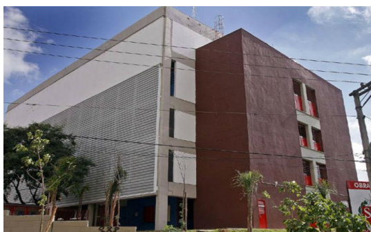
Figura 2 – Exemplo de construção sustentável: Escola Ilha da Juventude (SP)
