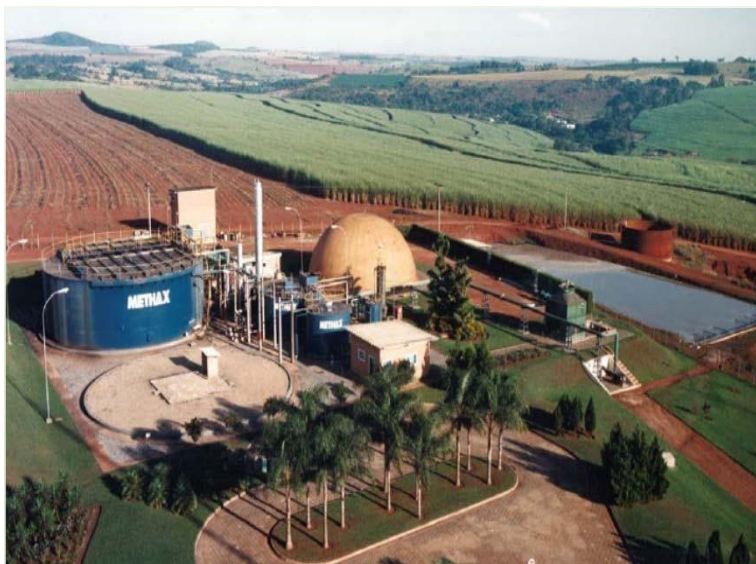
Figura 3 - Planta de biodigestão anaeróbica de vinhaça da Usina São João
