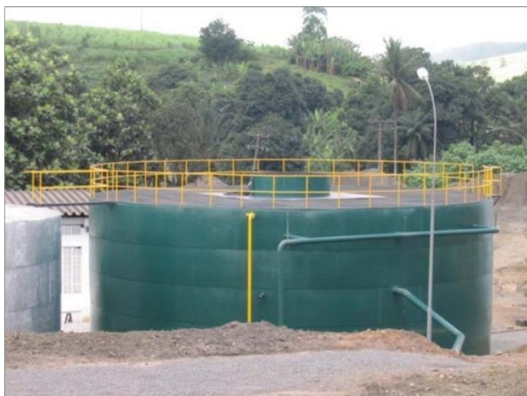
Figura 4 - Biodigestor instalado na Destilaria Inexport
