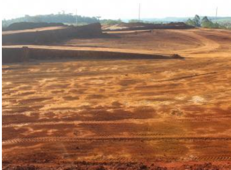
Figura 4 - Movimentação de terra no Pato Branco Shopping Fonte: Diário do Sudoeste (2017).
