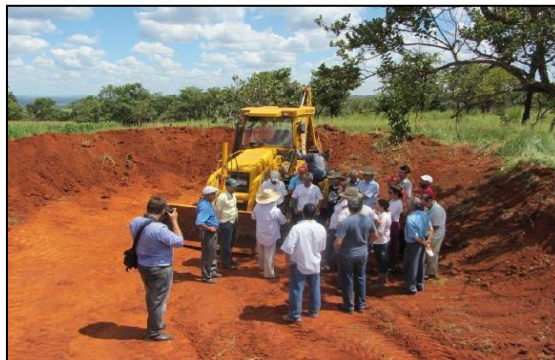
Figura 1 - Início da Construção de uma Barraginha
