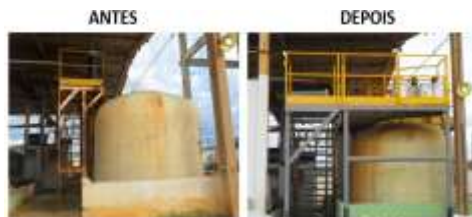
Figura 19: Antes e depois da manutenção na plataforma dos tanques. Fonte: Empresa
