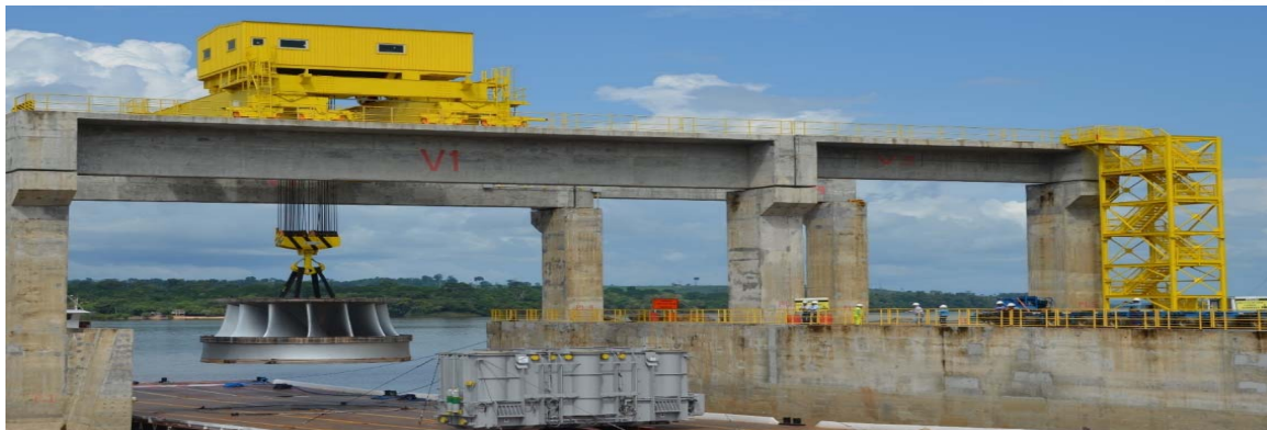
Figura 10: Desembarque de rotor na Estação de Transbordo de Carga por ponte rolante.
