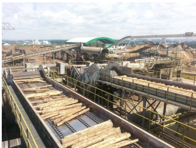
Fonte: Próprio Autor Figura 4 - Preparo de Madeira - Transportadores de entrada
