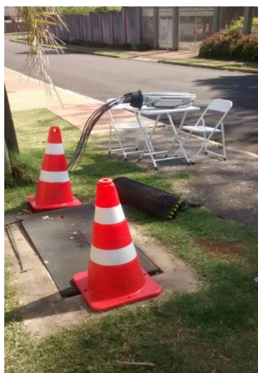
Figura 3: Guarita de caixa subterrânea Fonte: O autor, 2016.
