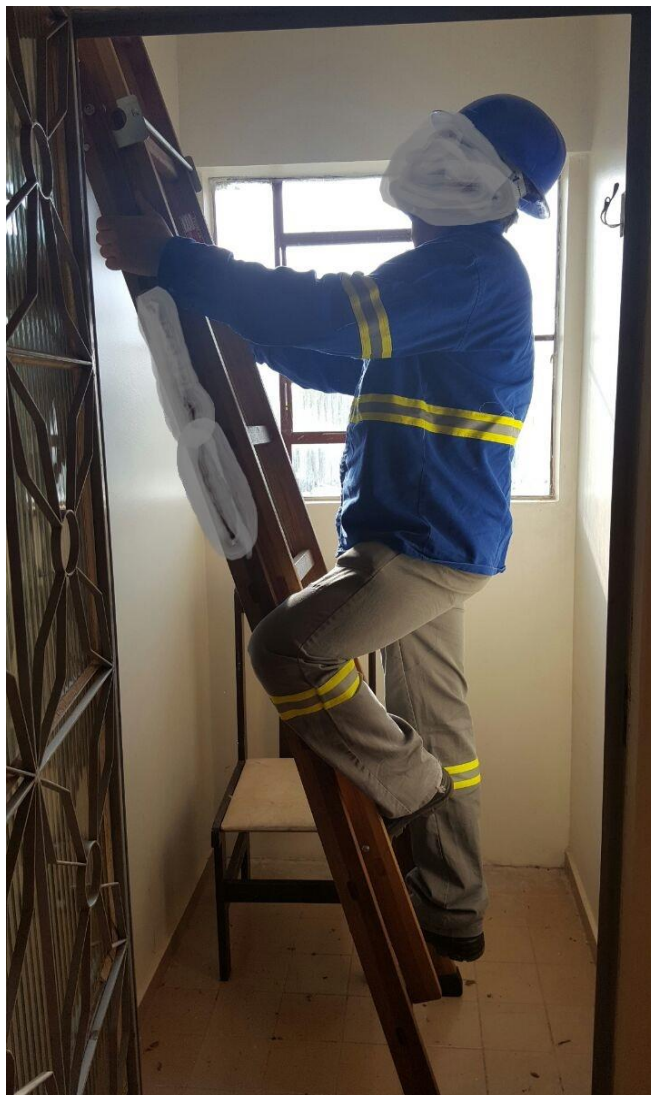
Figura 4: Instalador em atividade de instalação da fibra óptica Fonte: O autor, 2016.
