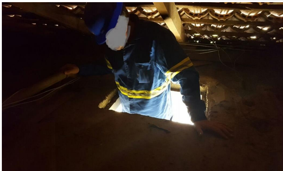
Figura 5: Trabalhador entrando no sótão através da sua pequena entrada. Fonte: O autor, 2016.
