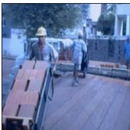
Figura 4 - Doca para recebimento de material e utilização de transpallets. Fonte: Empresa Alfa
