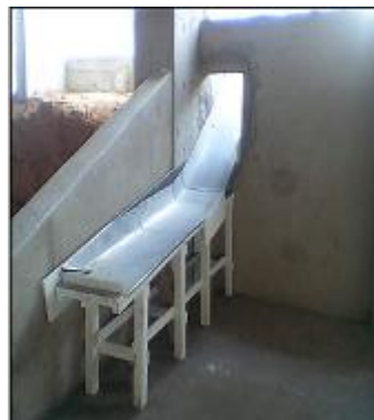
Figura 9 - Detalhe da rampa de recebimento das sacarias. Fonte: Empresa Alfa
