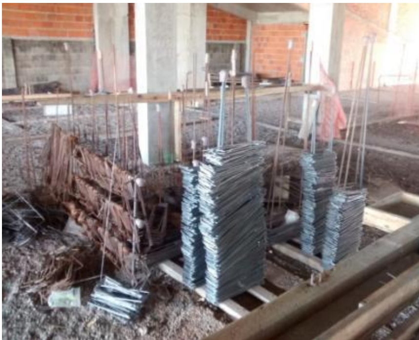
Figura 5 - Acondicionamento dos estribos Fonte: Autores
