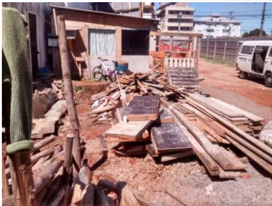
Figura 6 - Acondicionamento das madeiras de escoras Fonte: Autores
