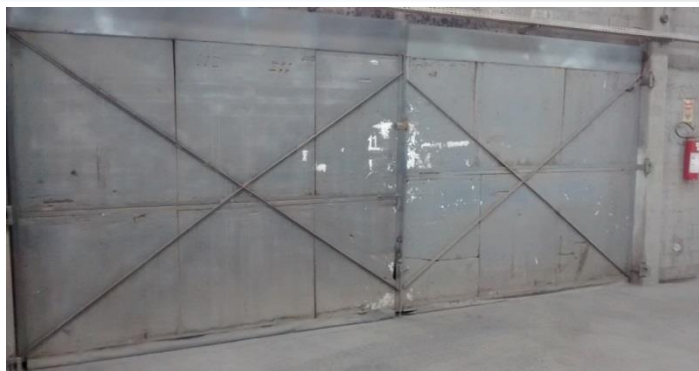
Figura 6: Detalhe da porta do forno de secagem
