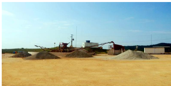
Figura 4 –Unidade de Beneficiamento de Resíduos de Construção e Demolição
