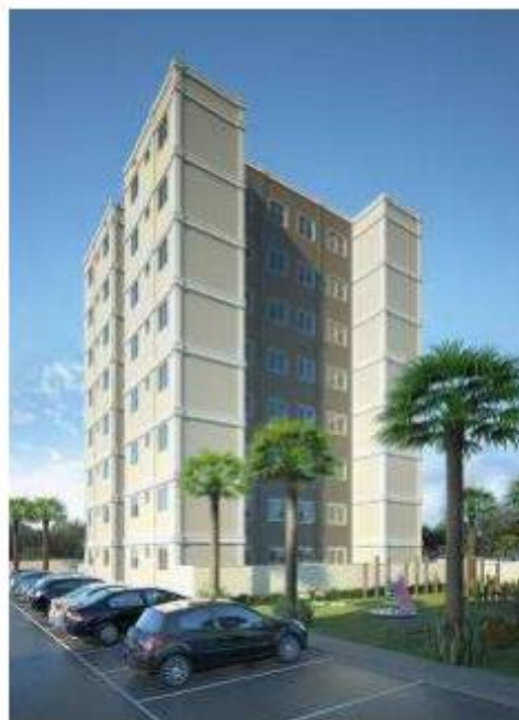
Figura 02 – Edificação com selo nível prata - Edifício Ville Barcelona.
