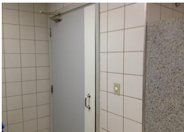
Figura 2 – Sistema de mola em uma porta de um banheiro
