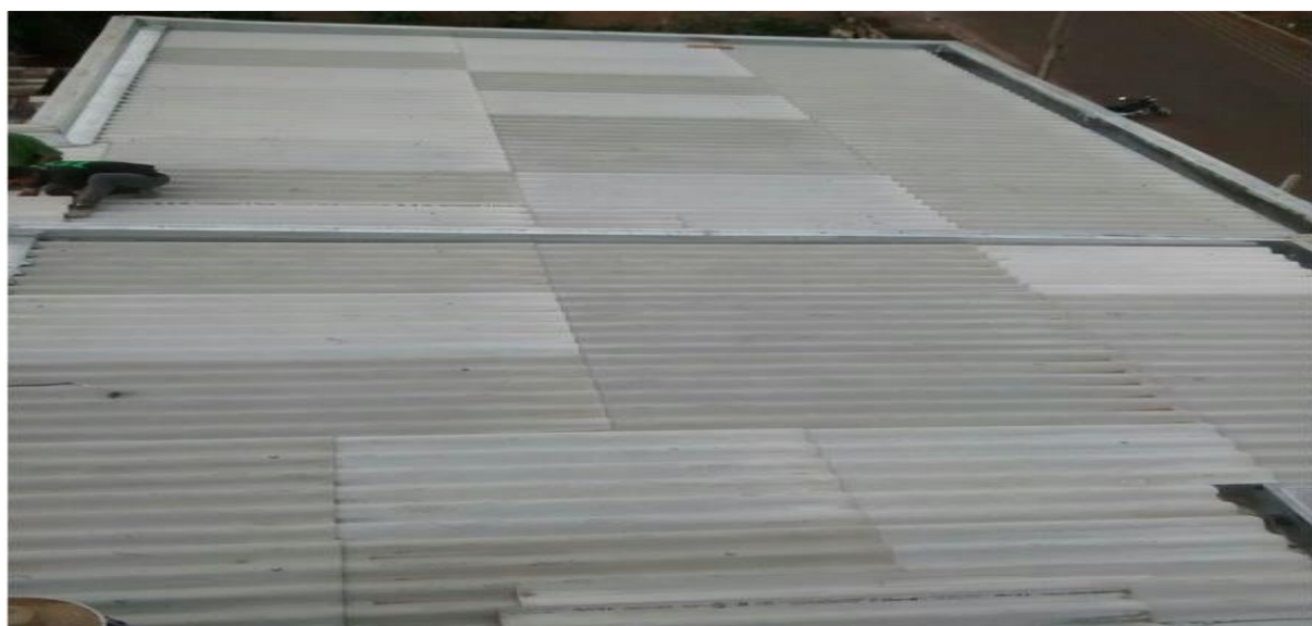
Figura 3: Telhado após a troca de telhas romanas por fibrocimento Fonte: autoria própria
