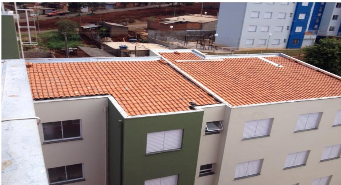
Figura 1: Telhado após colocação da lona plástica Fonte: autoria própria
