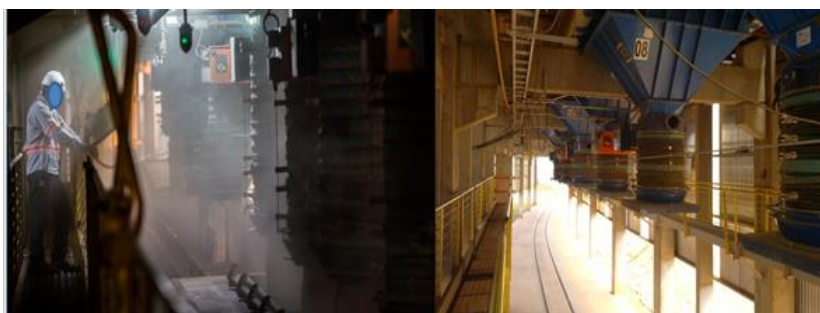
Figura 3: Tulha ferroviária (Fonte: Autoria Própria).
