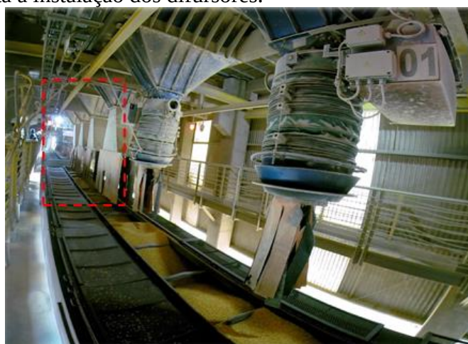
Figura 10: Instalação dos difusores (Fonte: Autoria Própria).
