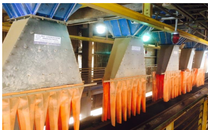
Figura 14: Instalação dos difusores na tulha ferroviária (Fonte: Autoria Própria)
