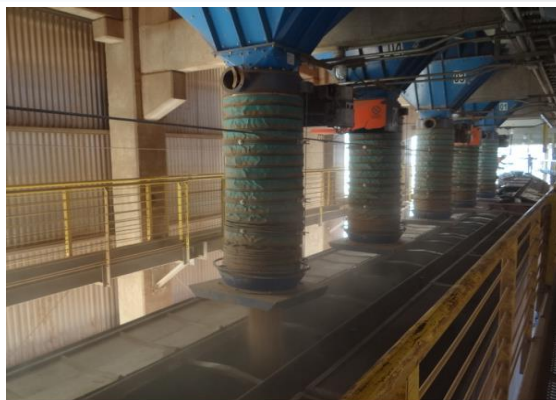
Figura 5: Tulha Ferroviária (Fonte: Autoria Própria).
