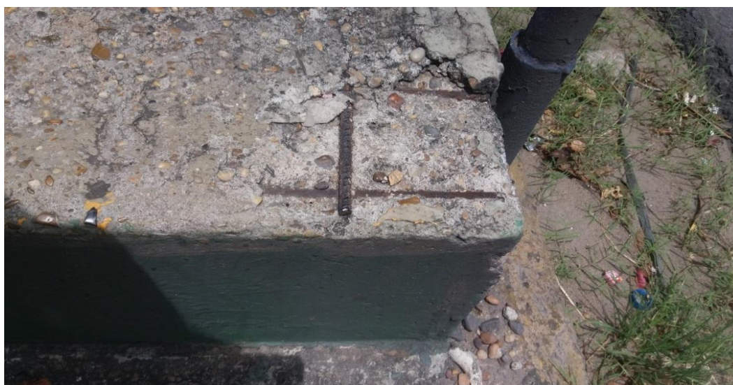
Figura 4: Armadura exposta por ação mecânica
