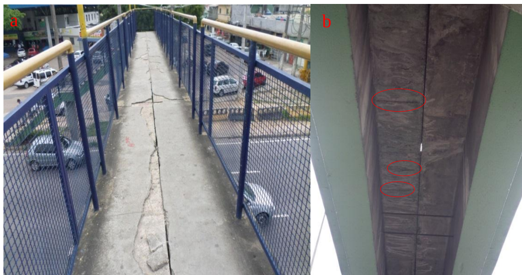
Figura 6: Deterioração da laje (a, b).
