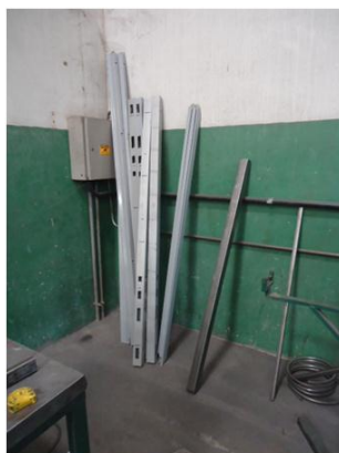
Figura 4: Material em local inadequado
