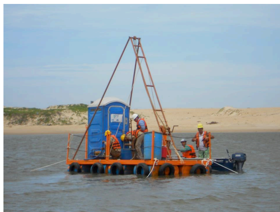
Figura 5 - Serviço de Sondagem SPT submersa sobre flutuante (Fonte: Empresa, 2015)
