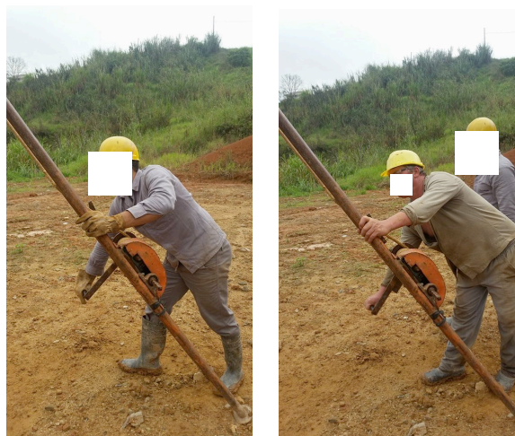
Figuras 4 - Operador utilizando os EPI's obrigatórios x Operador deixando de utilizar EPI's (Autores, 2015)
