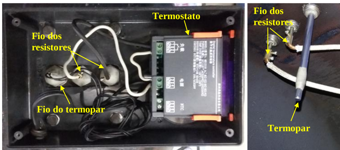
Figura 8 – Instalação do termostato, da alimentação dos resistores e do termopar
