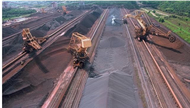
Figura 3 – Pátio de estocagem Sistema Norte, Carajás (Fonte: Vale, 2015)
