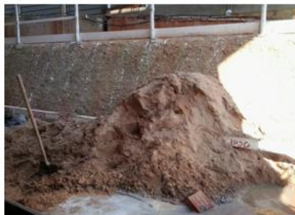
Figura 6: Estoque de Agregados Construtora A Fonte: Os autores (2014).
