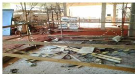
Figura 8: Estoques de Tubulações em PVC na obra da Empresa A Fonte: Os autores (2014).
