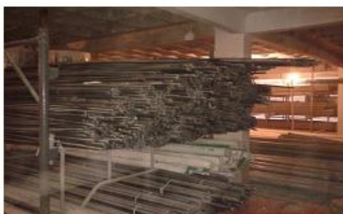
Figura 7: Estoques de Tubulações em PVC na obra da Empresa LEAN Fonte: Mourão e Valente (2013).
