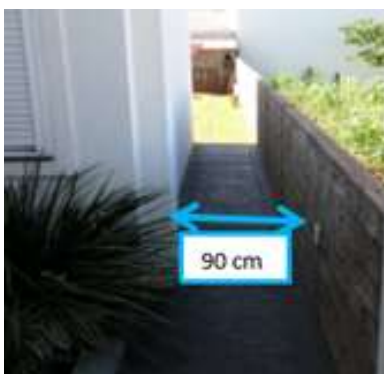
Imagem 2 – Passagem disponível para a movimentação de materiais
