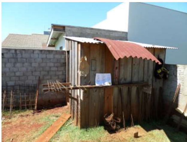
Imagem 4 – Casinha para depósito de ferramentas e materiais e bancada improvisada para amarrações
