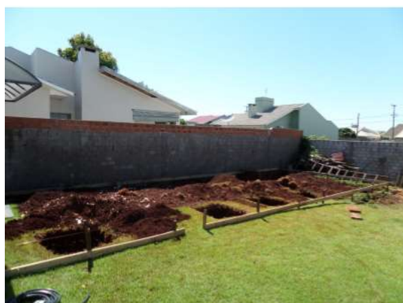
Imagem 1 – Panorama geral do canteiro de obras estudado
