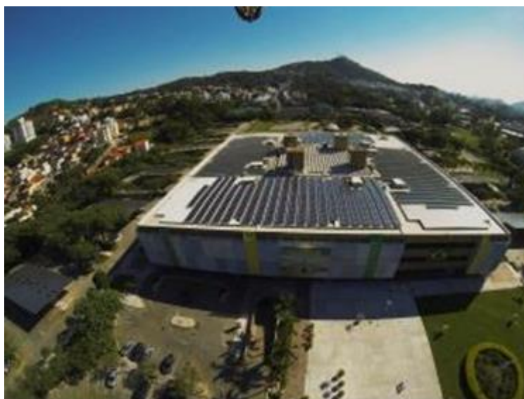
Figura 5 - Sistema fotovoltaico interligado à rede elétrica pública com potência instalada de 1 MWp. Tecnologias: Silício Amorfo (a-Si) e Silício Cristalino (c-Si). Fonte: Fotovoltaica UFSC, 2015.
