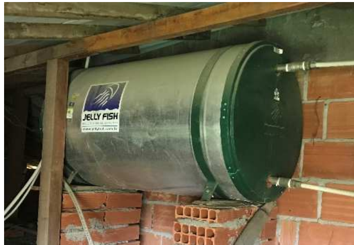
Figura 5. Reservatório instalado
