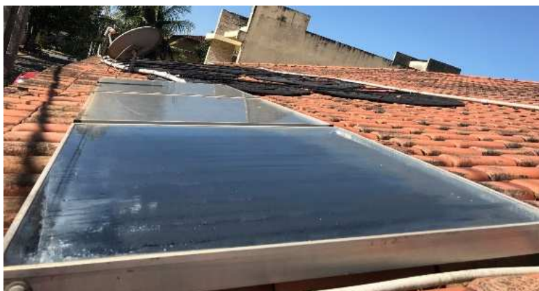
Figura 4. Instalação dos coletores solares
