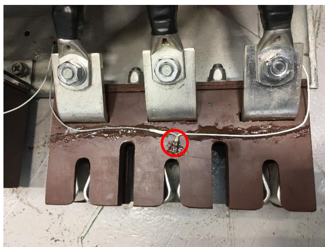
Figura 1 - Sensor instalado na garra de conexão
