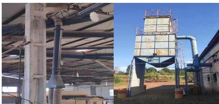
Figura 4 – Tubos de sucção e silo de armazenagem
